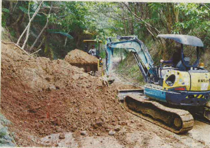
重機で土砂を撤去する県農林水産土木建設会石垣地区の会員ら = 6月30日午前、野底林道
